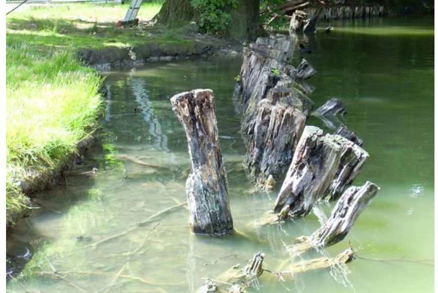
Ufereinfassung vergammelt und zerstört
